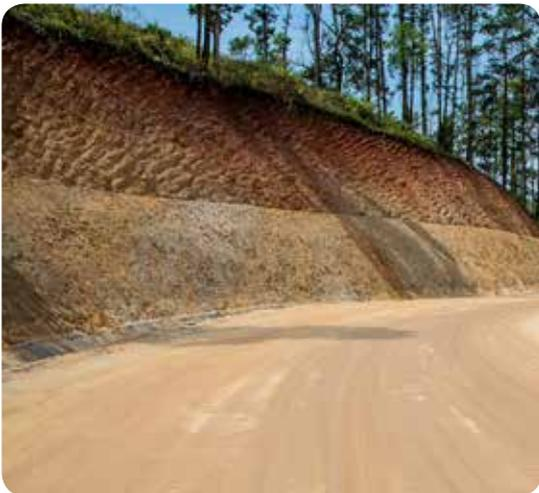
Ce nouveau produit polymérique respectueux de l'environnement protège la surface du talus face à l'érosion éolienne et hydrique principalement, formant une couche stabilisante, résistante, perméable et durable qui minimise les dégâts superficiels et la perte de sol.
